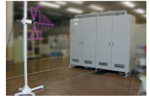
大型制御盤の出張測定
